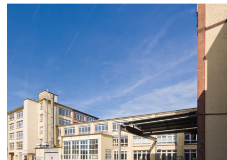
Frankfurt a.M., Westerbachstraße
